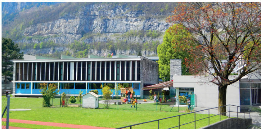
La salle de gymnastique de l'école primaire sera rénovée en 2021 © Brine 2011
