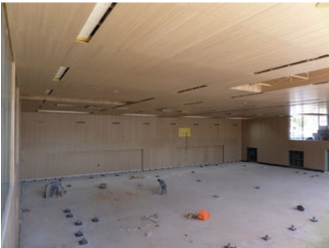
La salle de sport, prête pour recevoir la chape et le sol synthétique de type "Zurich"
