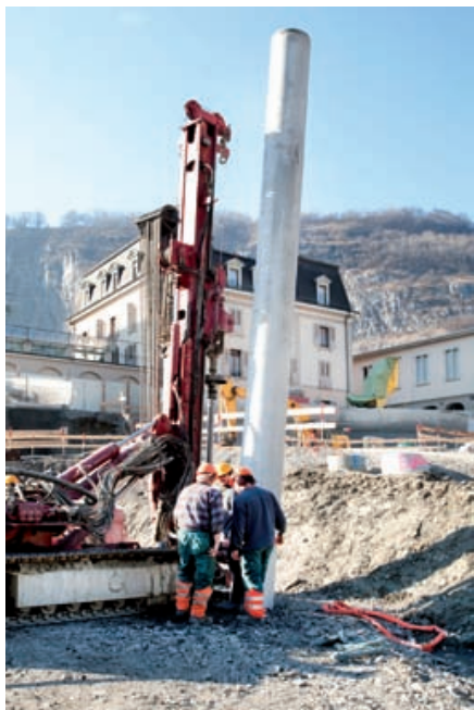
Un pieu fissuré est remplacé Photo Clin d'Œil
