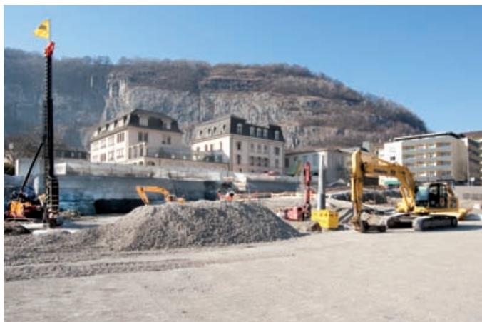
Battage des pieux des fondations des bâtiments Photo Clin d'Œil
