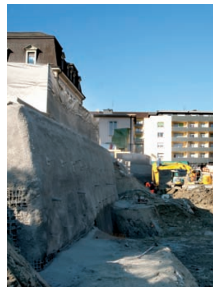
Paroi gunitée clouée Photo Clin d'Œil
