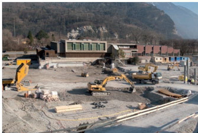
Travaux de terrassements Photo Clin d'Œil
