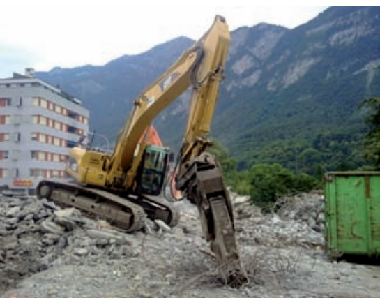
Il a fallu laisser refroidir la « pince » et lui accorder du repos à la fin des travaux de démolition.
