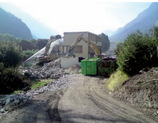
Le bâtiment 7 n'existe bientôt plus, pour laisser la place au nouveau CO.
