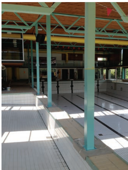
Etat final des colonnes assainies
