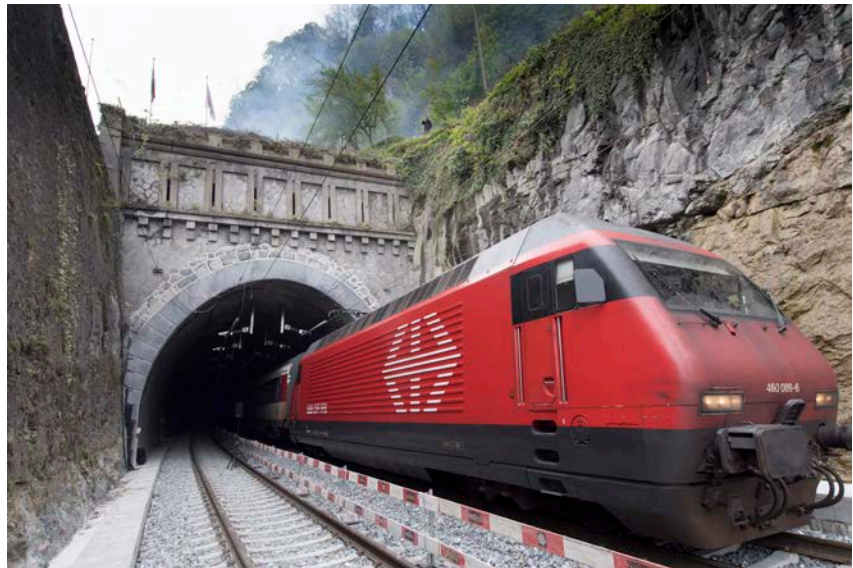
L'entrée nord du tunnel le jour de l'inauguration (photo : Keystone/Laurent Gilliéron)
